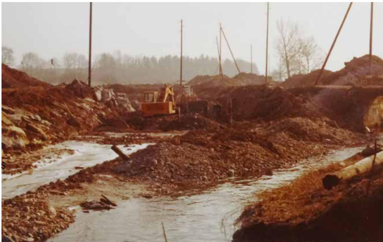
Wiggerverlegung oberhalb der Firma GIS; Links: neuer Wiggerlauf; rechts: alter Wiggerlauf.
